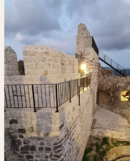
Onarım sonrası — sur duvarları
