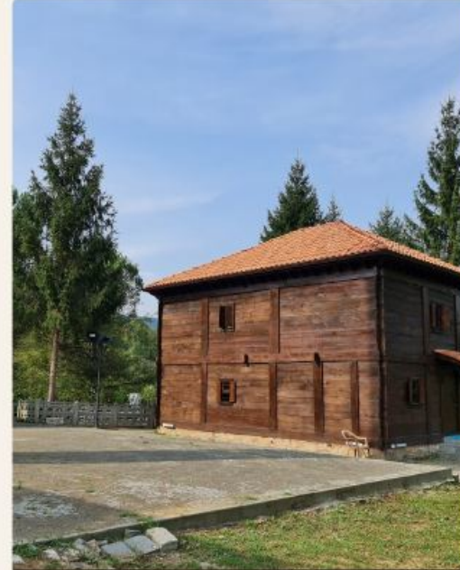
Onarım sonrası — dış cephe
