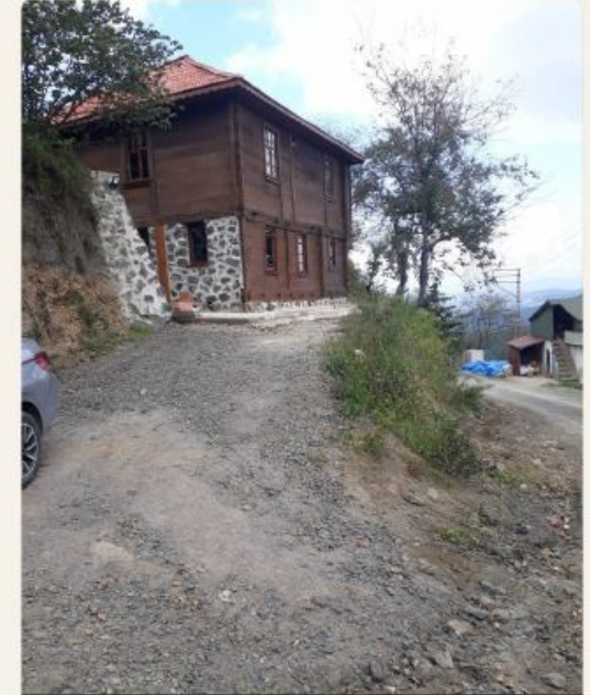
Onarım sonrası — dış cephe
